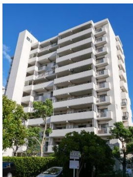
建物概観（中央公園側から）
