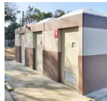
「防災トイレ」浜須賀小学校に昨年11月に設置されました。
